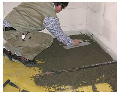
شکل ۳۷-۶ بتن‌ریزی کف شناور با استفاده از ملات مخصوص
