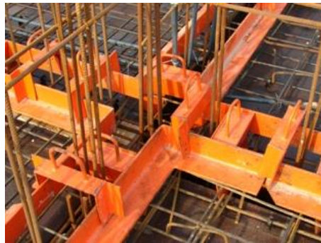
شکل ۱-۵۳ نمونه‌ای از قالب رامکا که قبل از بتن‌ریزی سقف
