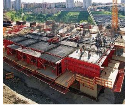
شکل ۱-۴۹ ساختمان بتن آرمه در دست احداث به روش قالب تونلی
