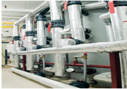
شکل ۴-۶ عایق کاری لوله با FEF
