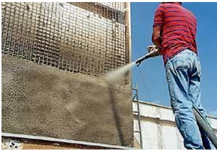
شکل ۱-۱۰ بتن پاشی بر روی پانل‌ها
