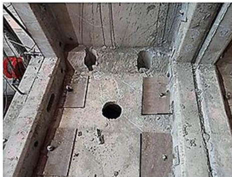
شکل ۱-۴۴ نحوه اتصال بلوک به فونداسیون
