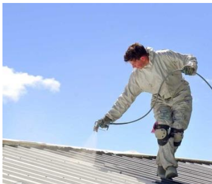
شکل ۶-۲۴ اجرای پوشش بازتابنده حرارتی
