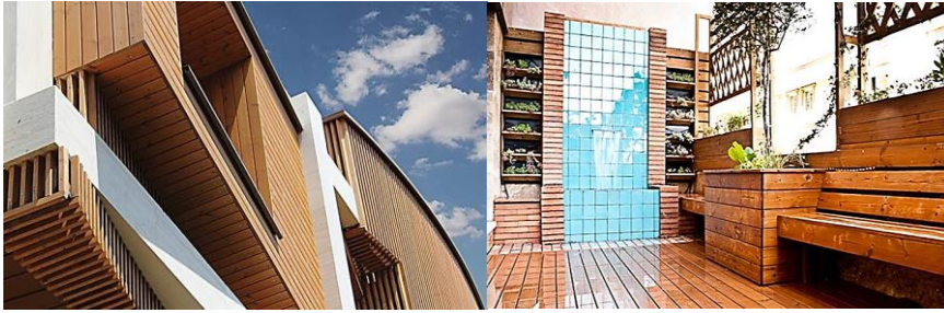
شکل ۵-۱۷ کاربرد ترمووود در خارج از ساختمان
