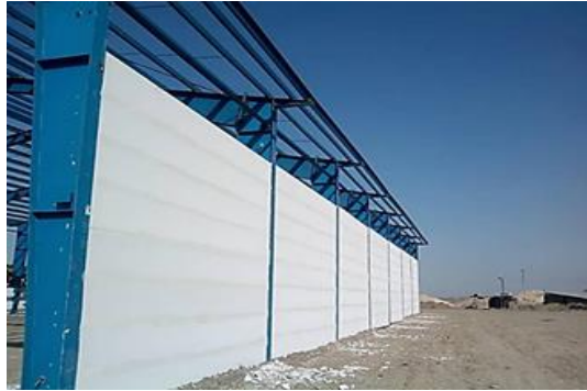
شکل ۳-۷ اجرای پانل AAC
