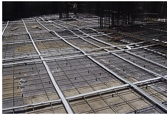
شکل ۲-۳۱ قراردادن غلاف‌ها بر روی سقف قبل از بتن ریزی
