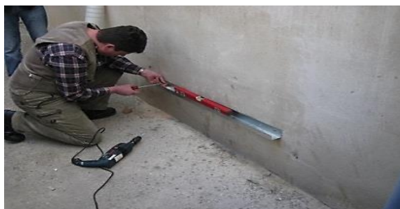
شکل ۵-۷ تراز کردن پروفیل U
