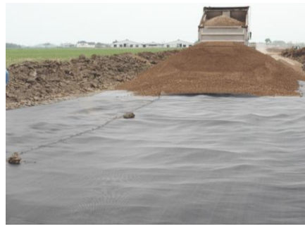
شکل ۴-۱۴ نمونه استفاده از ژئوتکستایل به عنوان مسلح کننده و جداساز لایه‌ها
