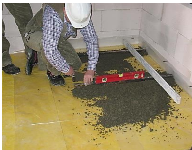
شکل ۳۷-۶ بتن‌ریزی کف شناور با استفاده از ملات مخصوص
