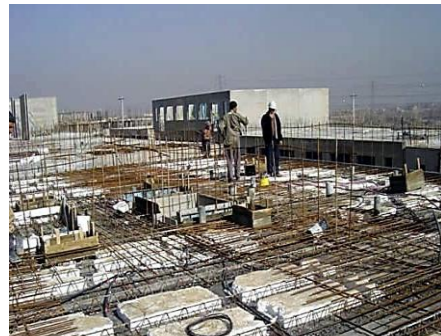
شکل ۵-۱ سقف پیش ساخته قبل از بتن‌ریزی
