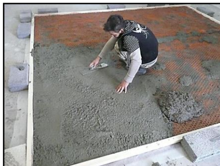
شکل ۶-۳۸ بتن‌ریزی معمولی با استفاده از شبکه مش
