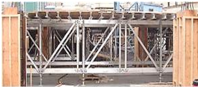
شکل ۵۵-۱ قالب‌های میز پرنده خریایی
