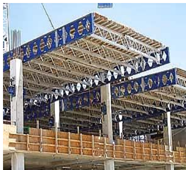
شکل ۱-۵۶ قالب پرنده و جزئیات نشیمن پیش بینی شده در ستون‌ها
