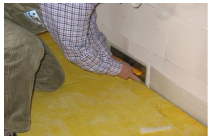
شکل ۳۵-۶ جداسازی کف شناور از دیوار به وسیله ماده الاستیک
