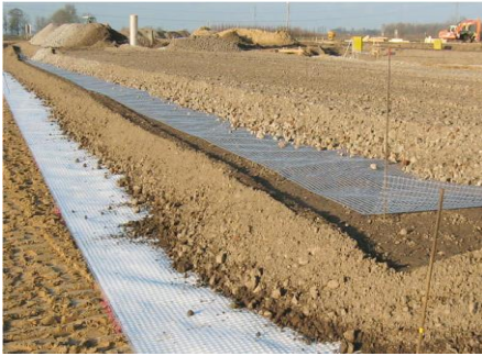
شکل ۴-۱۴ نمونه استفاده از ژئوتکستایل به عنوان مسلح کننده و جداساز لایه‌ها
