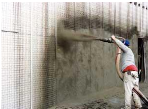
شکل ۱-۱۳ تصاویر مربوط به بتن پاشی پانل‌ها
