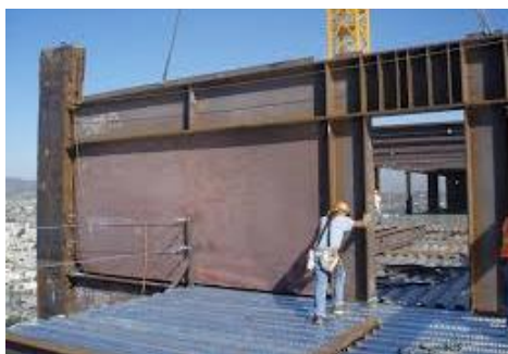
شکل ۱-۴۷ دیوار برشی فولادی
