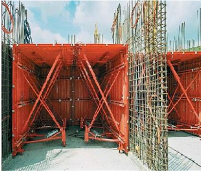
شکل ۱-۴۹ ساختمان بتن آرمه در دست احداث به روش قالب تونلی
