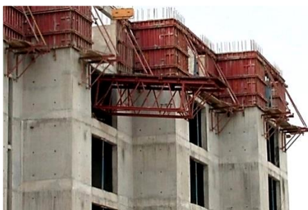
شکل ۱-۵۴ نمونه‌هایی از قالب میزپرنده در حال انتقال
