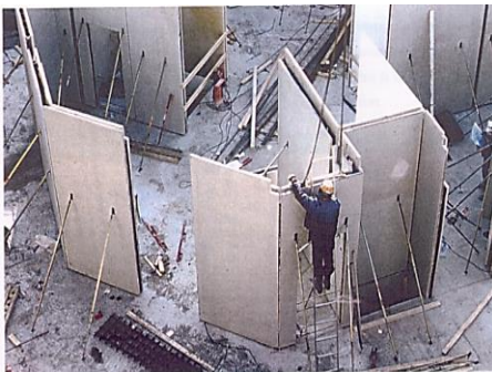
شکل ۶-۱ نصب پانل‌های دیوار در سیستم دیوار دولایه بتنی
