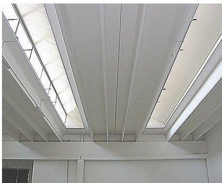
شکل ۲-۲۴ جزئیاتی از قطعات سقفی دابل تی
