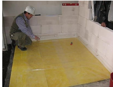
شکل ۳۶-۶ اجرای عایق رطوبتی بر روی ماده الاستیک برای جلوگیری از نفوذ آب بتن به داخل آن
