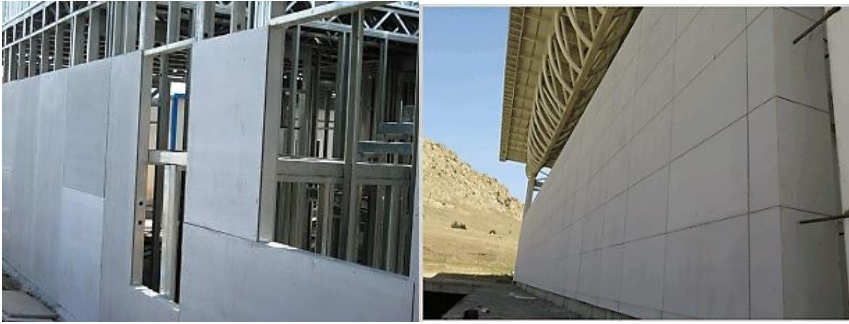
شکل ۴-۵ سیستم دیوار ایستا با صفحات سیمانی مسلح شده با الیاف
