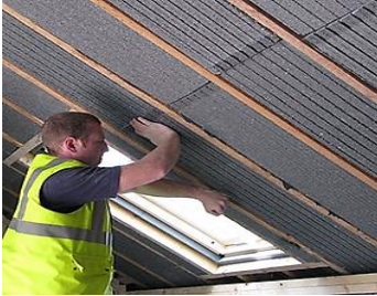
شکل ۶-۱۷ ساخت دیوار با پنل‌های شیشه سلولی شکل ۶-۱۸ عایق کاری بام شیب‌دار با پنل شیشه سلولی
