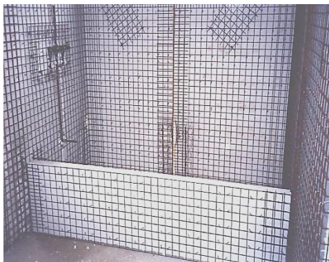
شکل ۱-۱۲ تاسیسات مکانیکی و برقی نصب شده بروی مجموعه پانل‌ها
