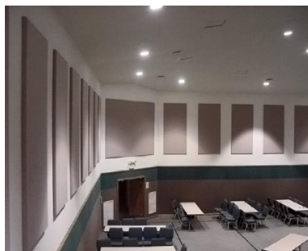
شکل ۳۱-۶ استفاده از پانل‌های آکوستیکی در دیوار
