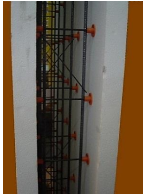
شکل ۱-۱۶ یک نمونه قالب ماندگار پانلی دارای میلگردگذاری در کارخانه
