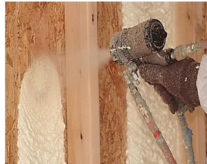
شکل ۶-۱۰ پاشش دو جز مخلوط شده به سطح دیوار
