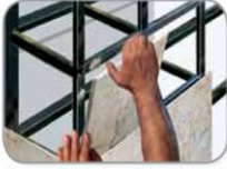
۳. نحوه نصب سنگ بر روی فرم فلزی
