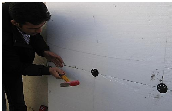
شکل ۵-۱۱ کوبیدن میخ پلاستیکی اتصال با چکش
