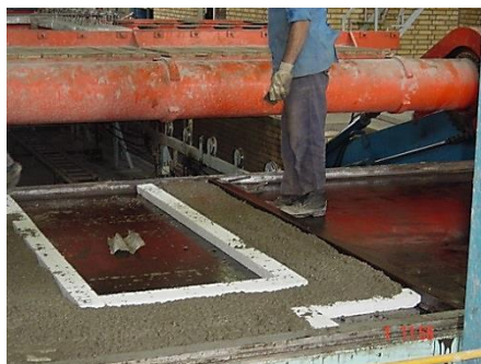
شکل ۷-۱ پانل دیوار در مرحله بتن‌ریزی و تراکم روی میز لرزان
