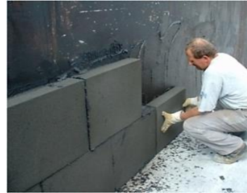
شکل ۶-۱۷ ساخت دیوار با پنل‌های شیشه سلولی شکل ۶-۱۸ عایق کاری بام شیب‌دار با پنل شیشه سلولی
