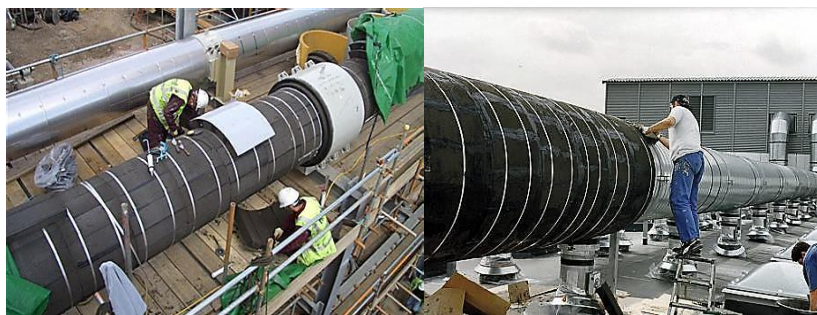
شکل ۱۶-۶ عایق‌کاری لوله‌های تاسیساتی با استفاده از پنل‌های شیشه سلولی
