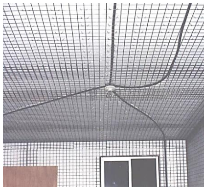
شکل ۱-۱۲ تاسیسات مکانیکی و برقی نصب شده بروی مجموعه پانل‌ها
