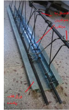
شکل ۲-۲ اتصالات تیرچه بدون جوش
