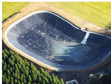
شکل ۴-۱۶ نمونه استفاده از ژئوممبرین‌ها در آب‌بندی کانال‌ها و حوضچه‌های مصنوعی
