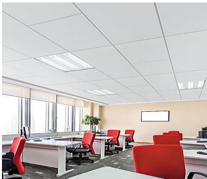
شکل ۶-۲۹ استفاده از تایل‌های آکوستیکی در سقف
