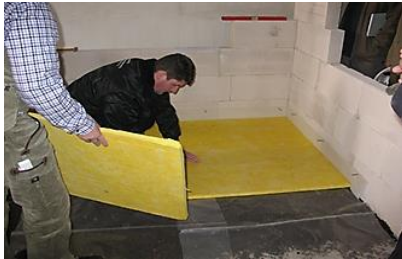
شکل ۳۴-۶ اجرای ماده الاستیک بر روی کف
