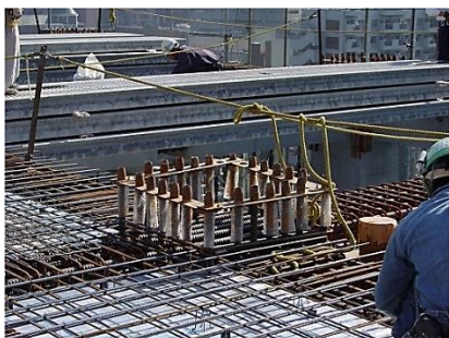
شکل ۱-۳۲ جزئیاتی از سیستم سازه‌ای R-PC به عنوان قاب خمشی بتن مسلح
