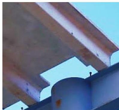
شکل ۲-۲۴ جزئیاتی از قطعات سقفی دابل تی
