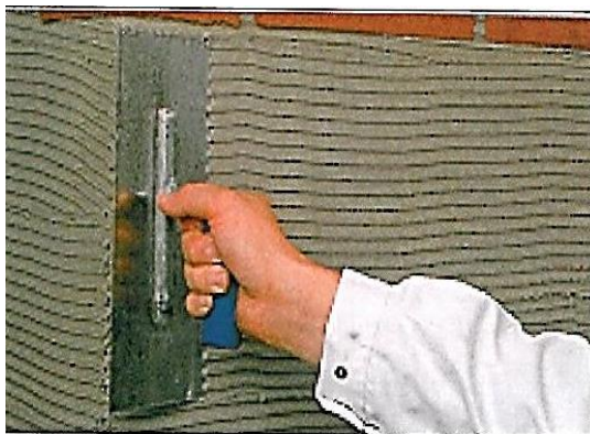
شکل ۵-۱۵ اجرای پوشش زیرین
