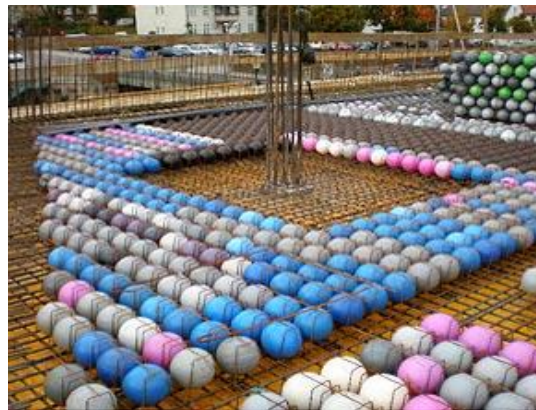
شکل ۲۸-۲ اجرای سقف توپر در اطراف ستون برای جلوگیری از برش پانچ
