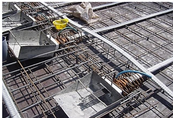
شکل ۲-۳۲ محل مهار انتهایی کابل‌ها قبل از کشش
