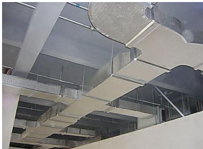
شکل ۶-۲۲ عایق کاری کانال‌های تهویه هوا
