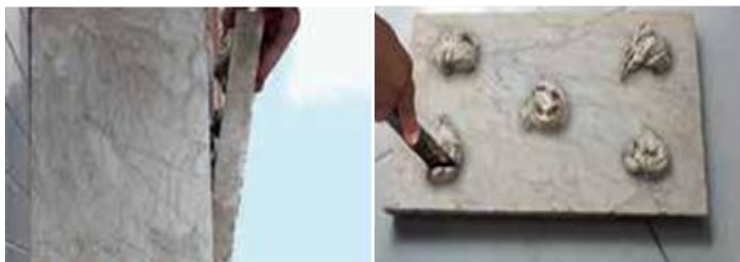
شکل ۴-۷ کندن قسمت‌های سست و لقمه گذاری
