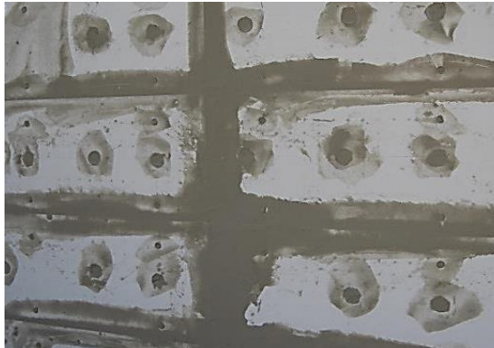
شکل ۱۲-۵ پوشاندن گل‌میخ‌ها با اندود زیرین
