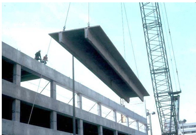
شکل ۲-۲۳ نمایی از یک قطعه در سقف دابل تی
