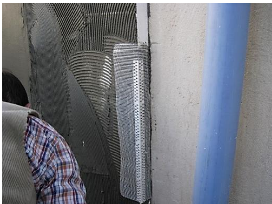
شکل ۵-۱۴ نصب پروفیل کنج
