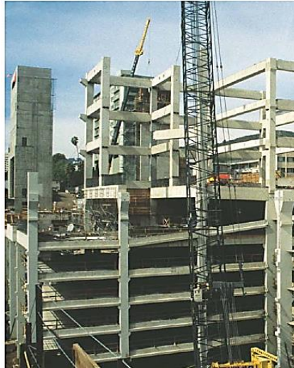
شکل ۱-۲۰ نمونه‌ای از قاب بتن مسلح پیش ساخته اجرا شده با ستون‌های پیوسته
