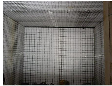
شکل ۱-۹ نصب پانل‌ها
