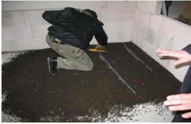
شکل ۳۳-۶ آماده سازی سطح کف برای اجرای کف شناور
