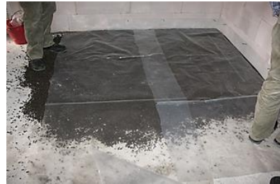
شکل ۳۴-۶ اجرای ماده الاستیک بر روی کف
