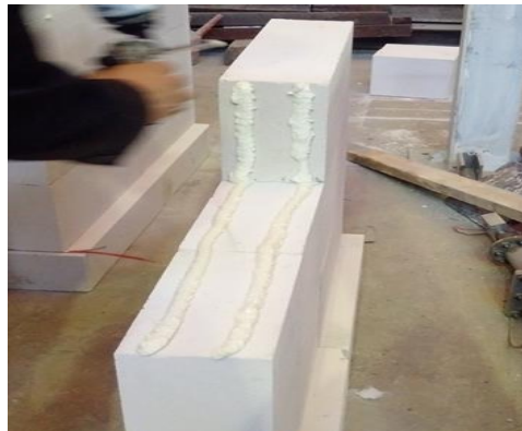
شکل ۴-۹ فوم ملات پلی یورتان با بلوک‌های AAC
