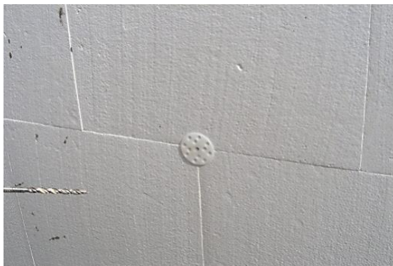
شکل ۵-۱۰ قرار گرفتن تخته‌ها به صورت یکی در میان (آجرچین)
