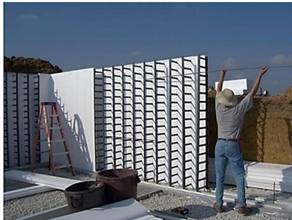
شکل ۱-۱۷ نمونه قالب ماندگار نواری قائم
