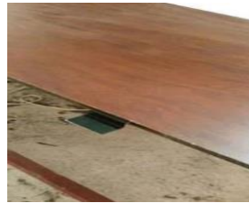
شکل ۵-۲۰ نصب ورق‌های HPL با استفاده از ایجاد شیار
