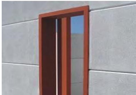
شکل ۱-۳۵ نصب نعل‌درگاه و بازشوها
