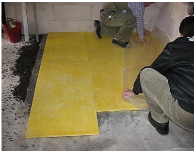
شکل ۳۶-۶ اجرای عایق رطوبتی بر روی ماده الاستیک برای جلوگیری از نفوذ آب بتن به داخل آن
