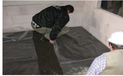
شکل ۳۳-۶ آماده سازی سطح کف برای اجرای کف شناور
