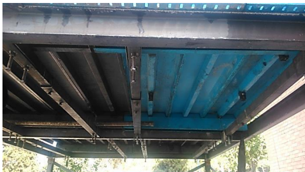
شکل ۲-۱۴ نمای زیرین قالب بندی سقف
