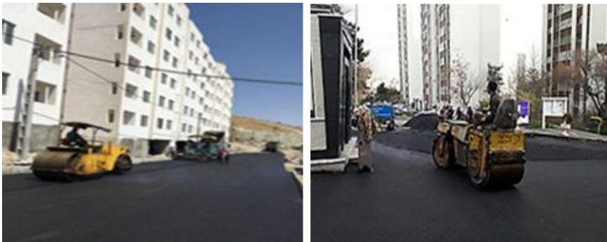
شکل ۴-۲۰ اجرای آسفالت پودرلاستیکی
