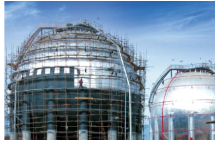
شکل ۳-۶ عایق کاری مخازن با FEF
